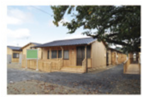
(写真左) 真備町に建設された 木造の集会所と仮設住宅
