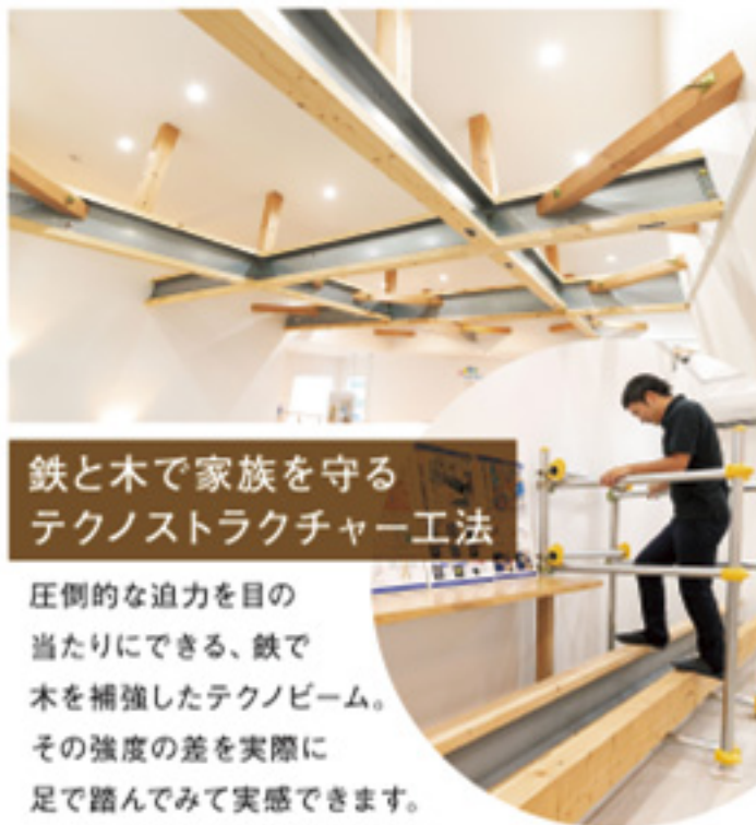
1/天井高2.7m、吹抜けは5.2m、約30畳の大空間にもかかわらず構造柱の必要がない。これこそが「テクノストラクチャー工法」の神髄です。
